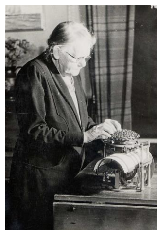
3 gamle fotografier. Til venstre: En "kugleskriver". Skrivekuglen er ganske høy, og bør derfor anbringes på et relativt lavt bord, for å få en god skrivestilling. I midten: Malling-Hansens oppfinnelse var gjenstand for stadige forbedringer, og finnes i en rekke utgaver. Antagelig ble gamle "kugler" framontert og satt på nyere modeller etter hvert. Til høyre: I annonsene for skrivekuglen het det at den kunne brukes av enhver, f.eks. av den som led av skjelving på hånden.
